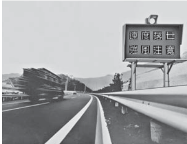
东名高速公路上所设置的世界首个道路气象信息系统（自动发出警报的电光显示屏）（1969年）
