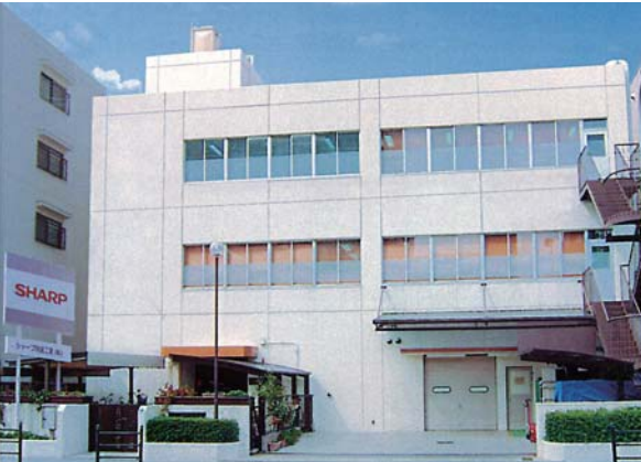
在地方支持下竣工的合资公司早川特选金属工厂新厂房（新工厂）
