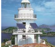
装有当时世界最大输出功率225W太阳能电池的御神岛灯塔（照片提供：海上保安厅）
