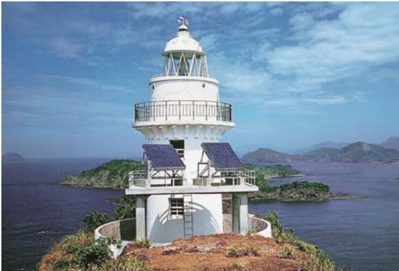
安装太阳能电池的御神岛（现在的尾上岛）灯塔（海上保安厅提供）
