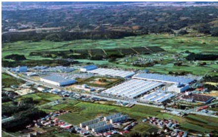
栃木事业所（栃木县矢板市）
