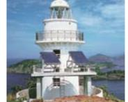
当時、世界最大の出力225Wの太陽電池を設置した御神島灯台(写真提供海上保安庁)
