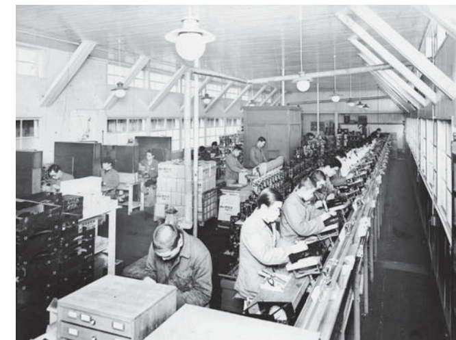
間歇式コンベアによるラジオ生産ライン(1936年ごろ)
