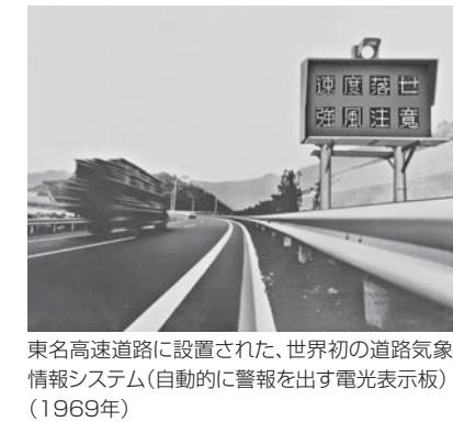
東名高速道路に設置された、世界初の道路気象情報システム(自動的に警報を出す電光表示板)
