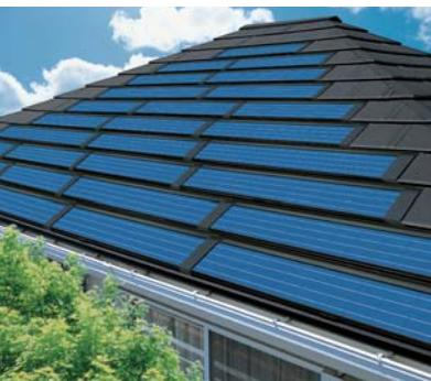
金属屋根一体型太陽光発電システム
