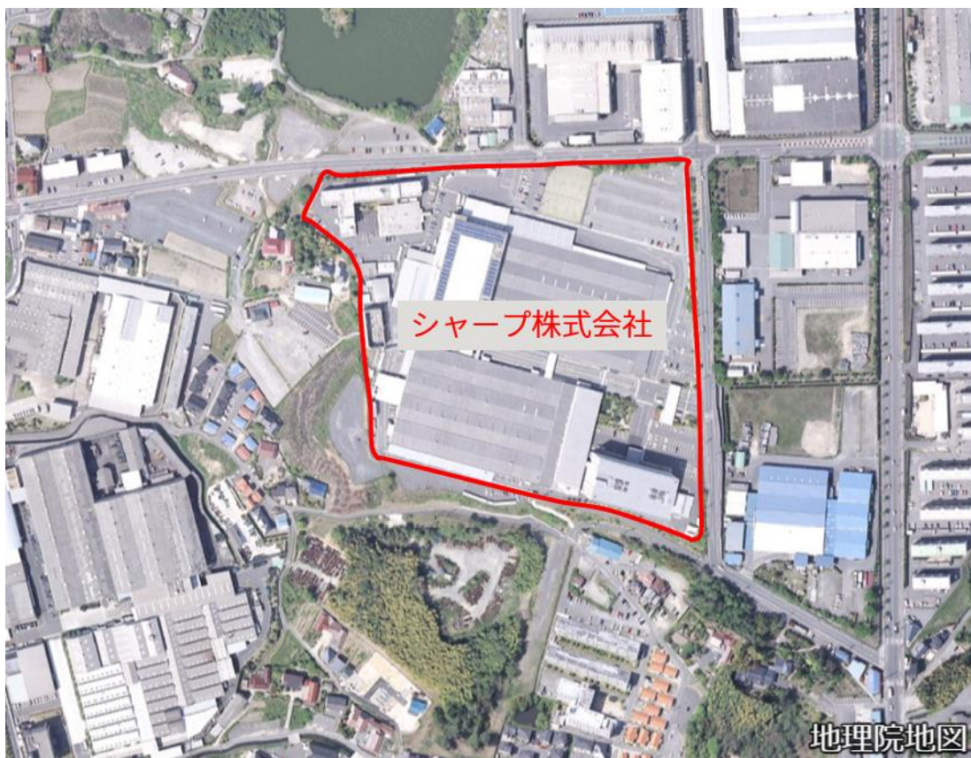
図 2.1-1 シャープ(株)通信事業本部、上空からの俯瞰図
