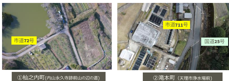
図 2.1-76 道路検査のドローン撮影風景
