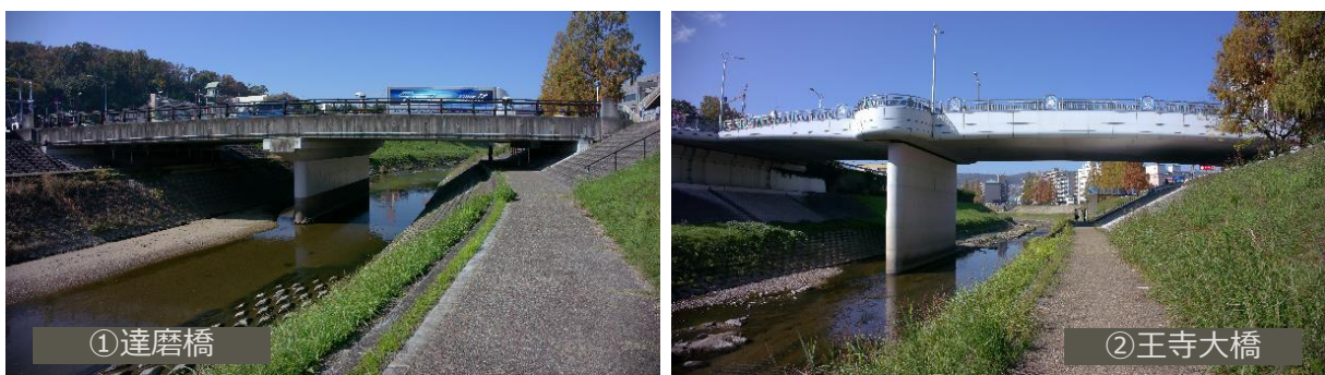
図 2.1-44 橋梁点検の撮影風景
