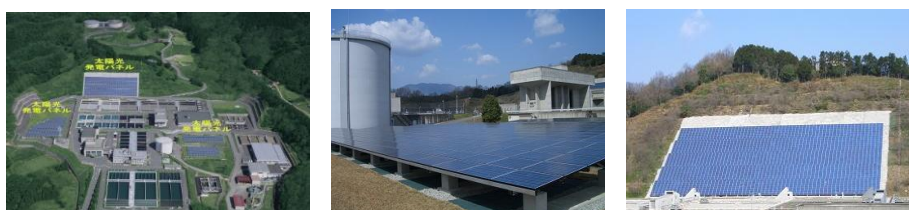
・ 図 2.1-84 奈良県水道局の太陽光発電システム
