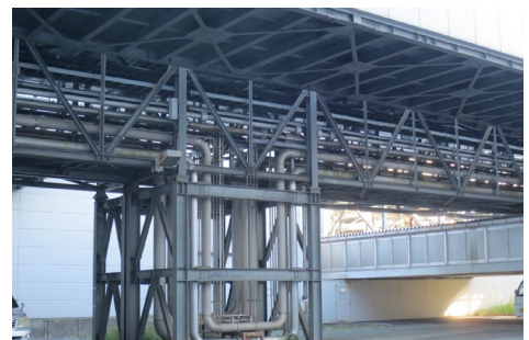
配管は高架橋に設置
