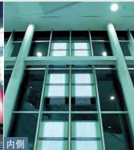
综合商业设施 Alfronte (千叶县松户市) 正面采用晶硅薄膜透明太阳能电池与白色发光二极管一体成型的发光太阳能电池“Lumiwal”
