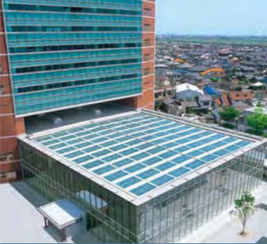
三重县铃鹿市厅（晶硅薄膜透明太阳能电池模块）
