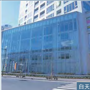
综合商业设施 Alfronte (千叶县松户市) 正面采用晶硅薄膜透明太阳能电池与白色发光二极管一体成型的发光太阳能电池“Lumiwal”
