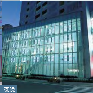
综合商业设施 Alfronte (千叶县松户市) 正面采用晶硅薄膜透明太阳能电池与白色发光二极管一体成型的发光太阳能电池“Lumiwal”
