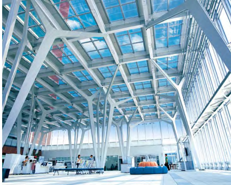
天窗采用了夏普透明薄膜式太阳能电池模组(日本三重县铃鹿市政府办公楼) (照片是晴天时的室内景象)
