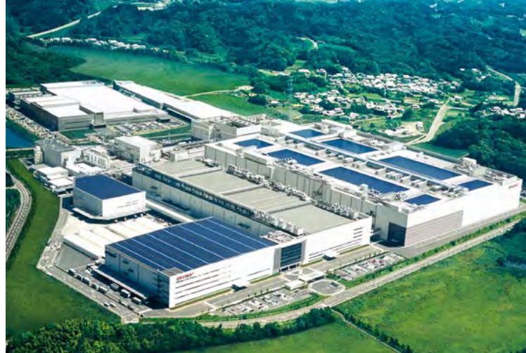
龟山工厂(日本三重县龟山市)
