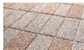
人行道铺设了具有渗水性地砖
