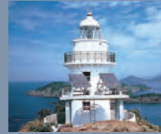
长崎县尾上岛灯塔上的太阳能发电系统 (1966年设置时的照片) 照片提供：海上保安厅
