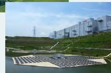
亀山市と連携して工場に隣接する調整池に200kWのフロート型太陽光発電システムを設置し、実証実験を実施
