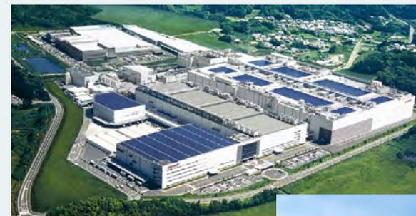
工場の屋根と壁面に5,210kWの太陽光発電システムを導入
