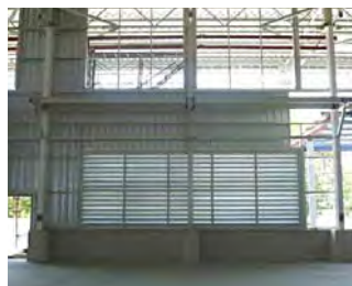
外壁大型ルーバーからの給気
