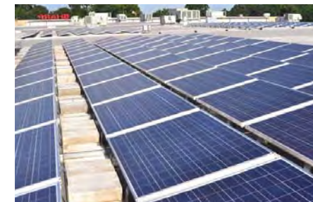
事業所の屋根に設置した太陽光発電システム
