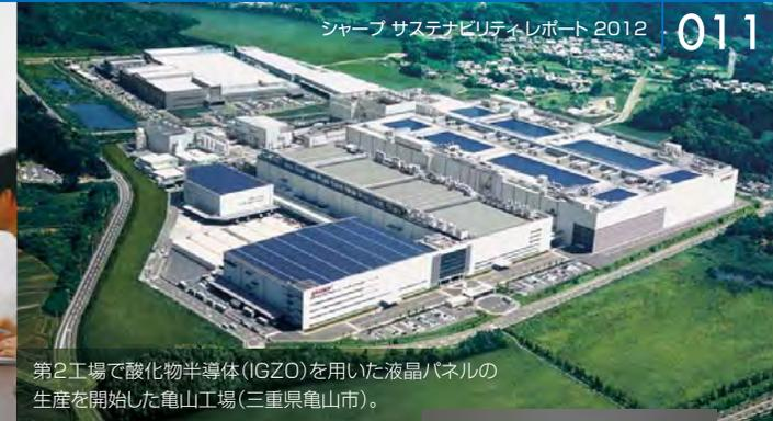
第2工場で酸化半導体(IGZO)を用いた液晶パネルの生産を開始した亀山工場(三重県亀山市)。
