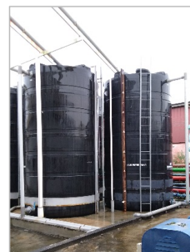
工場に設置された雨水タンク
