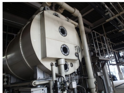
洗浄廃液の一部を社内設備で蒸発・濃縮
