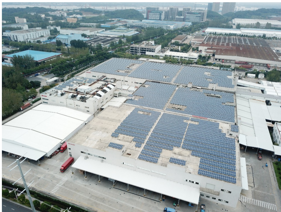
工場の屋根に設置された太陽光発電システム
