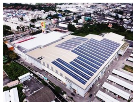
店舗の屋根に太陽電池モジュールを設置
