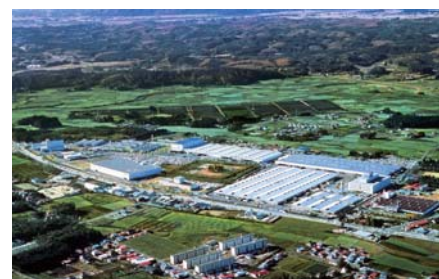
栃木事业所 (栃木县矢板市)
