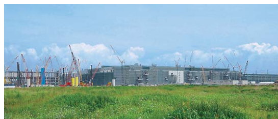
建設中の液晶パネル新工場（2008年7月現在）
