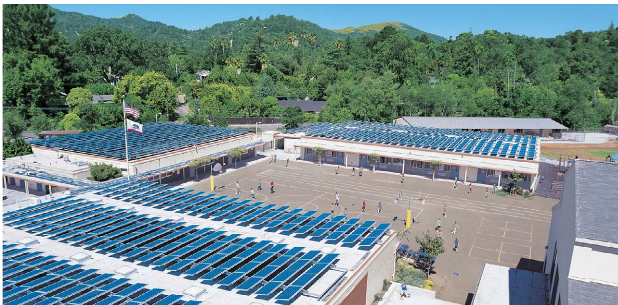
カリフォルニア州の小学校に導入された太陽光発電システム
