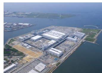
大阪府堺市に建設中の21世紀型コンビナート(2009年5月現在)
