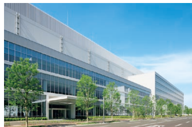
「グリーンフロント 堺」の液晶パネル工場
