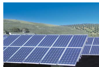
シャープ及びエネル・グリーン・パワー社による南イタリアの太陽光発電所
