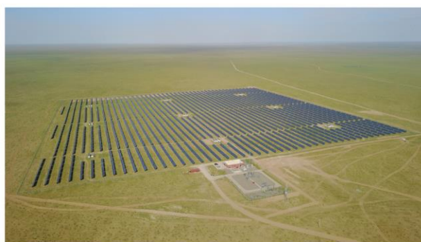
建設した太陽光発電所
