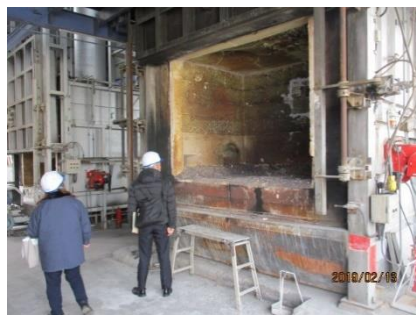
廃油処理施設(焼却炉)
