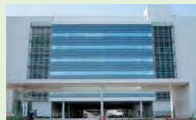
亀山工場(正面)の太陽光発電システム設置事例
