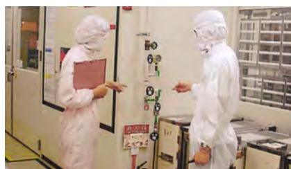
消火器など常設品類の固定位置や、配管の開閉を明示し確認しています。
