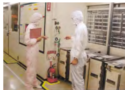
消火器など常設備品類の固定位置や、配管の開閉を明示し確認しています。
