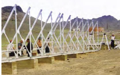
大自然の中に組み立てられたフレーム
