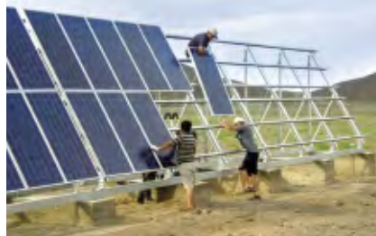
太陽電池モジュールが次々と取り付けられていく
