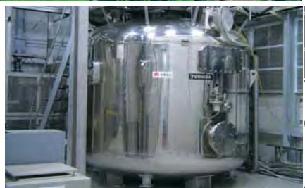
当瞬间电压降低时,可供给电力的10MVA超导电电力贮藏装置
