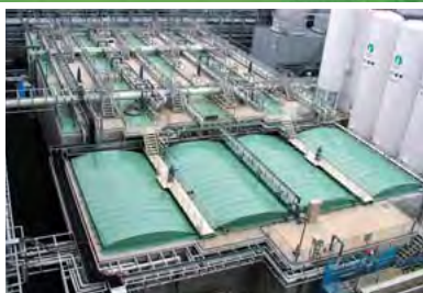
将工程排水100%循环利用的排水设备
