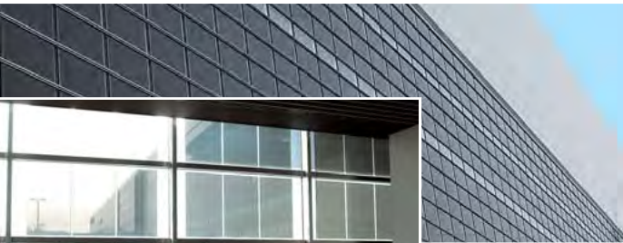
第二工厂外墙设置有结晶薄膜透明太阳能电池模块
