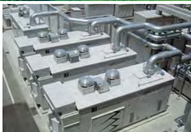
日本国内最大的1,000kW燃料电池系统
