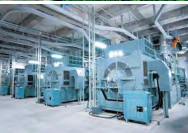
工厂全部电力约1/3的自家发电系统同时供电供热系统
