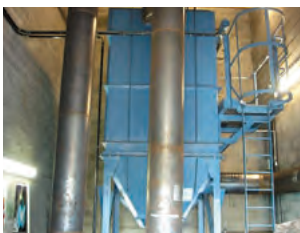
真空粉塵回収システムの導入
