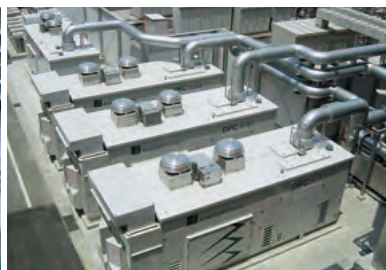
国内最大1,000kW燃料電池システム
