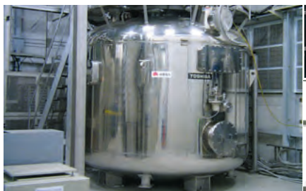
瞬時電圧低下時に電力を供給する10MVA 超電導電力貯蔵装置
