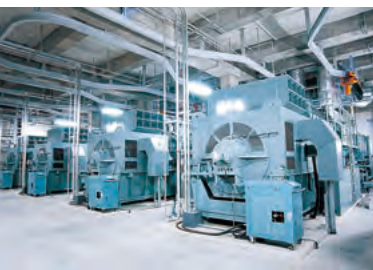
工場全体の電力の約1/3を自家発電するコ・ジェネレーションシステム
