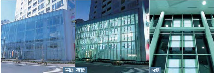
結晶薄膜シースルー太陽電池と白色LEDを組み合わせた「光る太陽電池」[ルミウォール]を正面に採用いただいた複合商業施設アルフレンテ様(千葉県松戸市)
