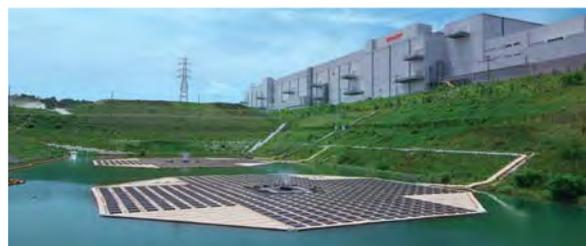
亀山工場に隣接する調整池に設置したフロート型太陽光発電システム
