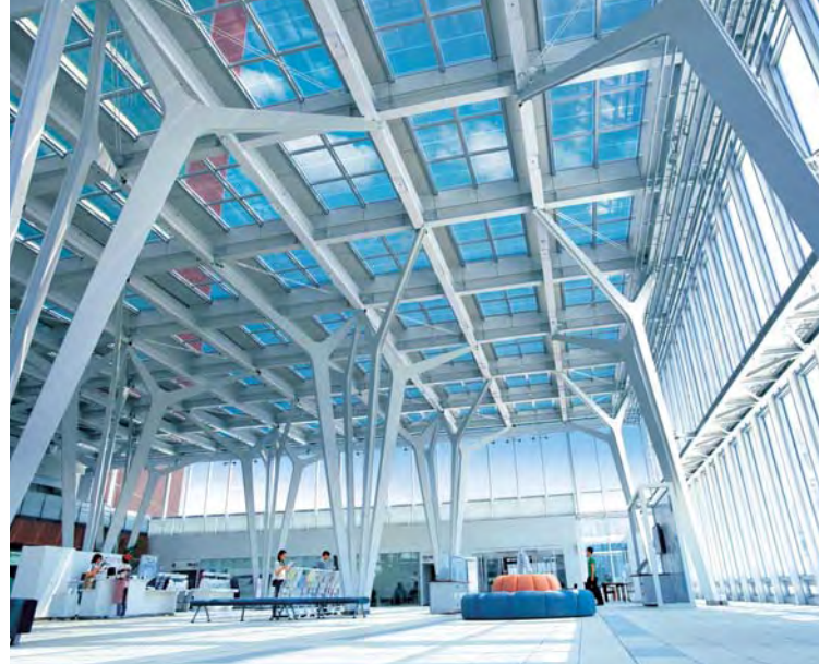
薄膜シーソー太陽電池モジュールをトップライトに採用(三重県・鈴鹿市庁舎) 写真は晴天時に実際に見た様子を再現したものです。
