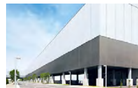
车间间搬运系统
