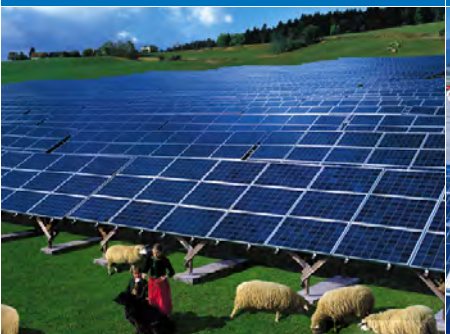
德国拜人州松嫩太阳能发电站
