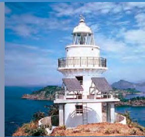
长崎县尾上岛灯塔上的 太阳能发电系统 (1966年设置时的照片) 照片提供 海上保安厅
