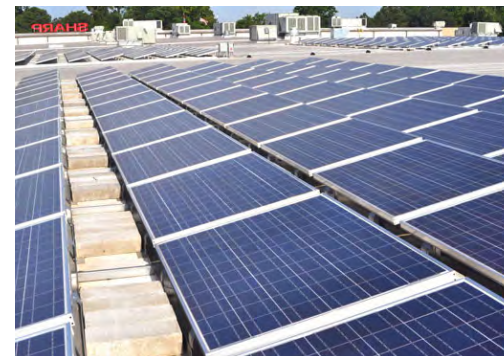
设置在事业所屋顶的太阳能发电系统
