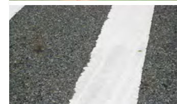
将玻璃废料作为隔热材料(上)及道路行车线的颜料有效利用
