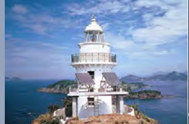
长崎县尾上岛灯塔上的太阳能发电系统 照片提供:海上保安厅
