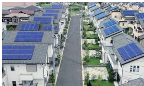
船桥日大前站的安装事例
