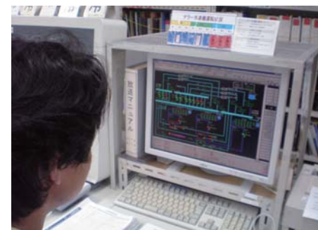
确认冷冻机的运行情况
