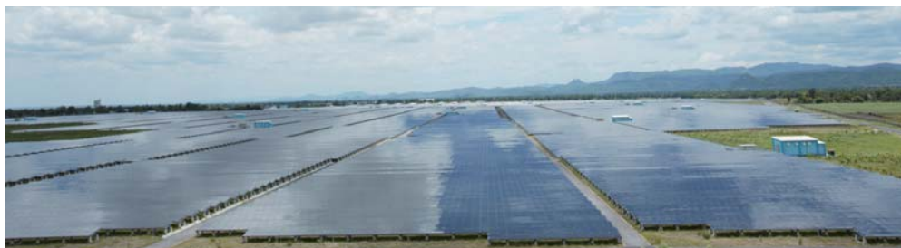
兆瓦级太阳能发电站(泰国洛布里县)
