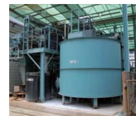
改造空调涂装生产线的污水处理设备
