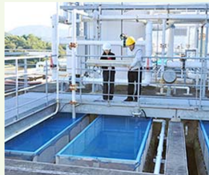
繁殖させた微生物で薬品を分解する水槽
