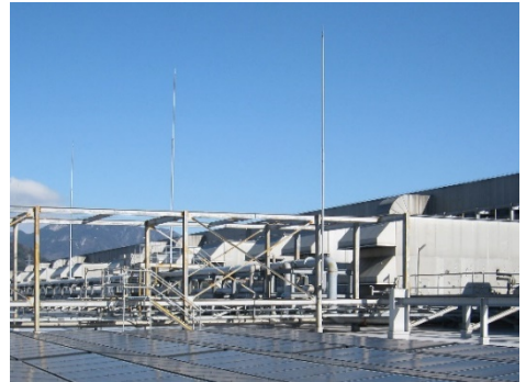
工場屋上に並ぶ外調機
