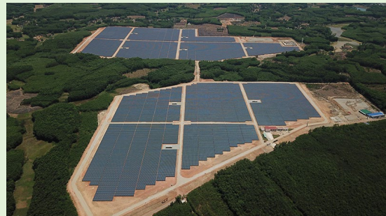
運転を開始した太陽光発電所
