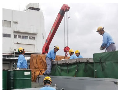
PCB廃棄物搬出作業
