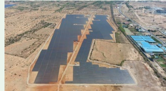
ニントゥアン省に建設した太陽光発電所（メガソーラー）
