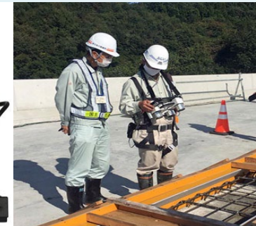
配筋検査の様相
