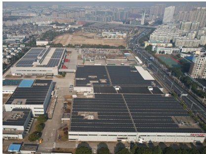
生産拠点の屋根に設置された太陽光発電システム（左：中国・SOCC 右：タイ・SATL）
