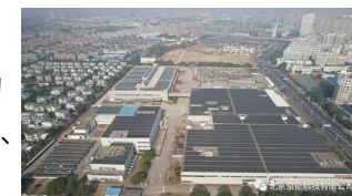
SOCC工場全景
