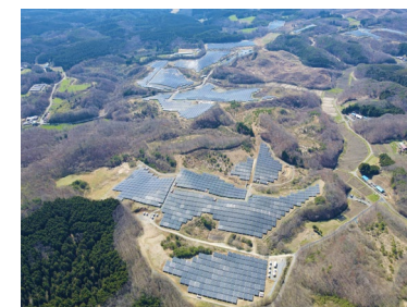
鮫川青生野太陽光発電所
