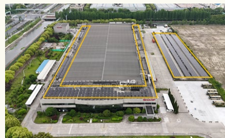
太陽光発電設備
