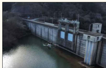
ダム点検管理のローカル5G実証実験
