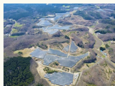
鮫川青生野太陽光発電所
