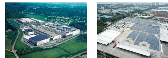
生産拠点の屋根に設置された太陽光発電システム（左：亀山 右：NSEC）
