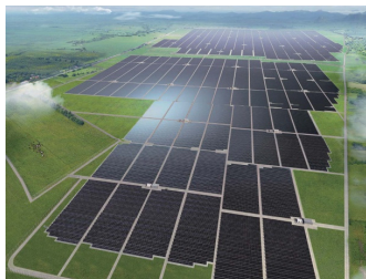
タイ(ロップリ県)に建設中の世界最大級の太陽光発電所(73MW、2011年末に運転開始予定。)
