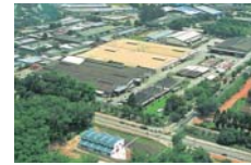
●マレーシアの生産会社 SRC シャープ・ロキシー・コーポレーション 〈ケダ州 スンガイベタニ〉
