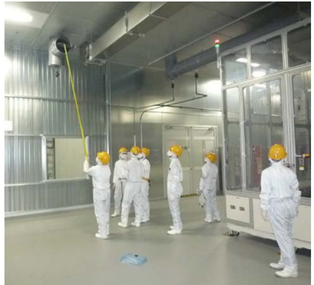
<小集団活動において工場内省エネ巡視点検を実施>
