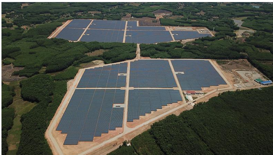
建設した太陽光発電所
