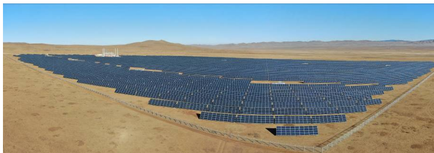
建設した太陽光発電所
