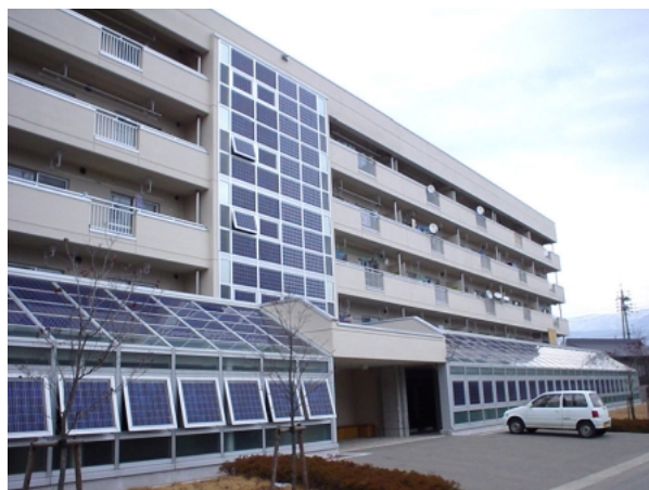
写真1 太陽電池アレイ外観写真 Photo 1 Outside view of PV array.
