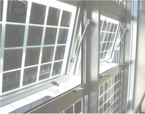
写真2 壁面の内観（採光部分） Photo 2 Inside view (light-through area).
