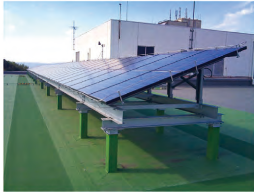
薄膜太陽電池 6kW 多結晶太陽電池 6kW
