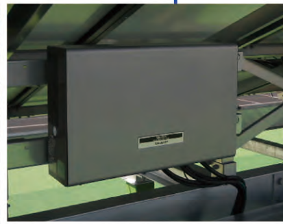
パワーコンディショナー： 4.5kW 4台
