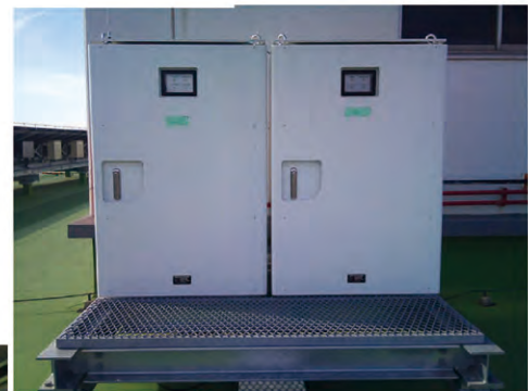
蓄電池： 34 kWh 17.2 kWh × 2 リチウムイオン電池
