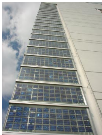
写真5 設置事例(採光窓一体型)
