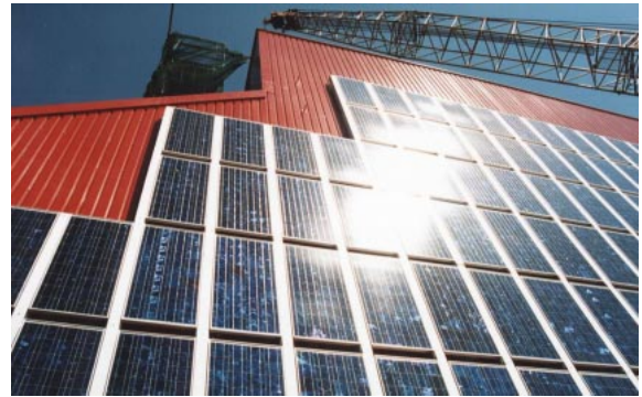
写真4 設置事例(壁面設置型)
