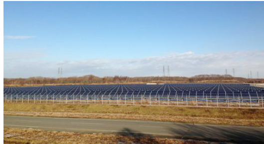
図2 シャープ苫小牧第一太陽光発電所 (設置容量: 約2.6MW-DC, 年間予測発電量: 約288万kWh)
