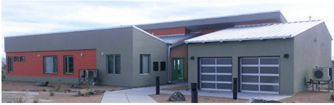
図1 スマートハウス外観 Fig.1 Overview of the smart house.
