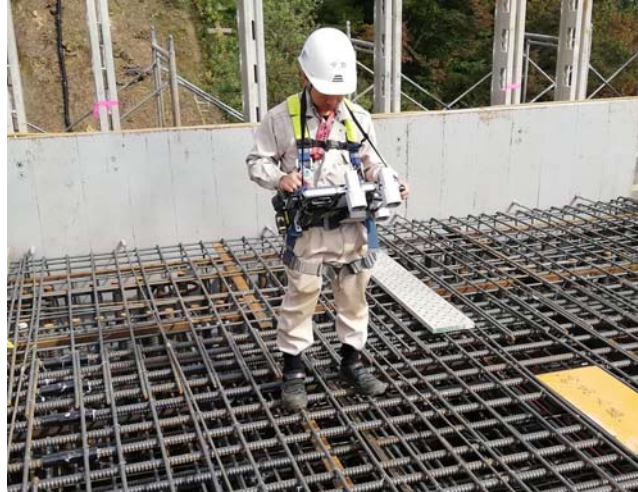
3眼カメラ配筋検査システムの使用イメージ
