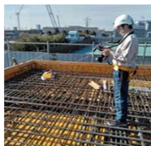
本システムを使用した検査
