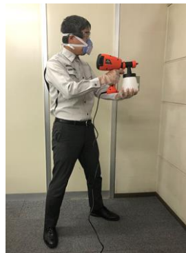
左：光触媒溶剤、右：壁面への光触媒溶剤吹き付け作業（イメージ）
