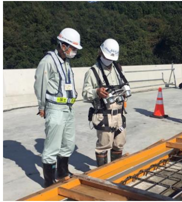
3眼カメラ配筋検査システムを使用した検査の様様
