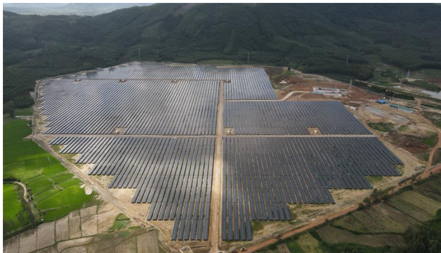
建設した太陽光発電所
